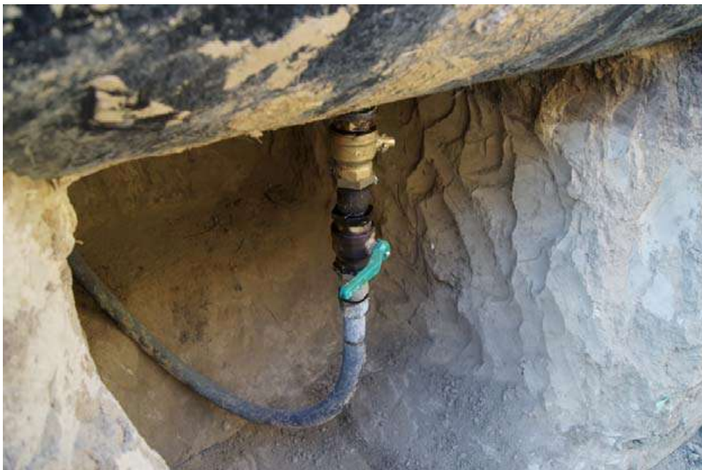
Рис. 3. Вид квалифицированной врезки в трубопровод.
