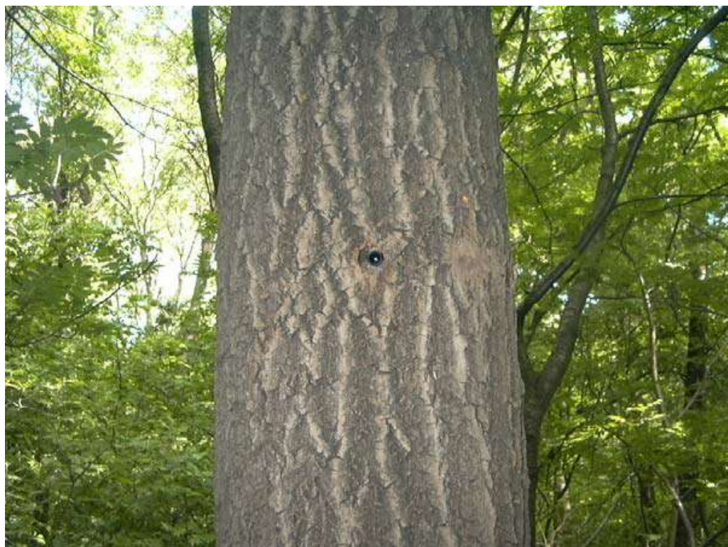
Рис. 16. Вид замаскированной видеокамеры, установленной в стволе дерева для наблюдения за врезкой в трубопровод.
