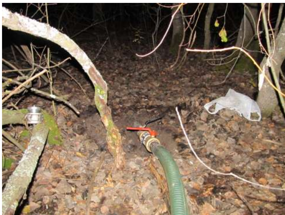
Рис. 12. Вид замаскированного отвода от врезки в трубопровод с присоединенным к нему шлангом, ведущим к емкости автомобиля, предназначенного для перевозки похищенных нефти и нефтепродуктов.
