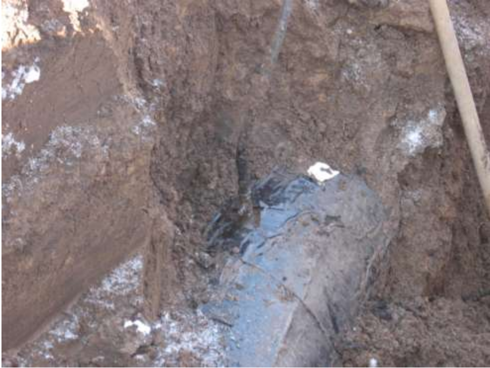
Рис. 1. Вид квалифицированной врезки в трубопровод.
