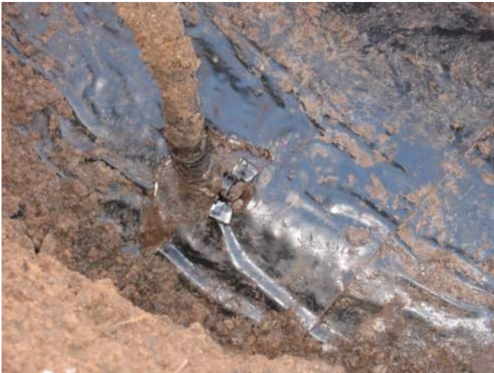
Рис. 2. Вид квалифицированной врезки в трубопровод.
