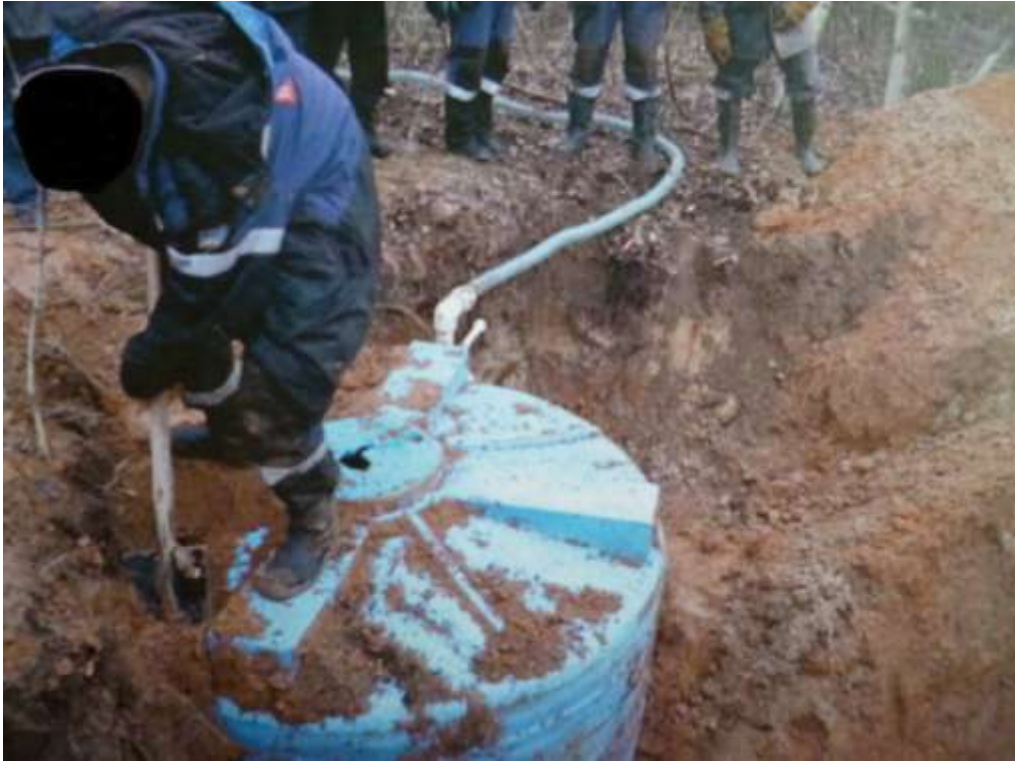
Рис. 7. Вид накопительной емкости, замаскированной под землей.
