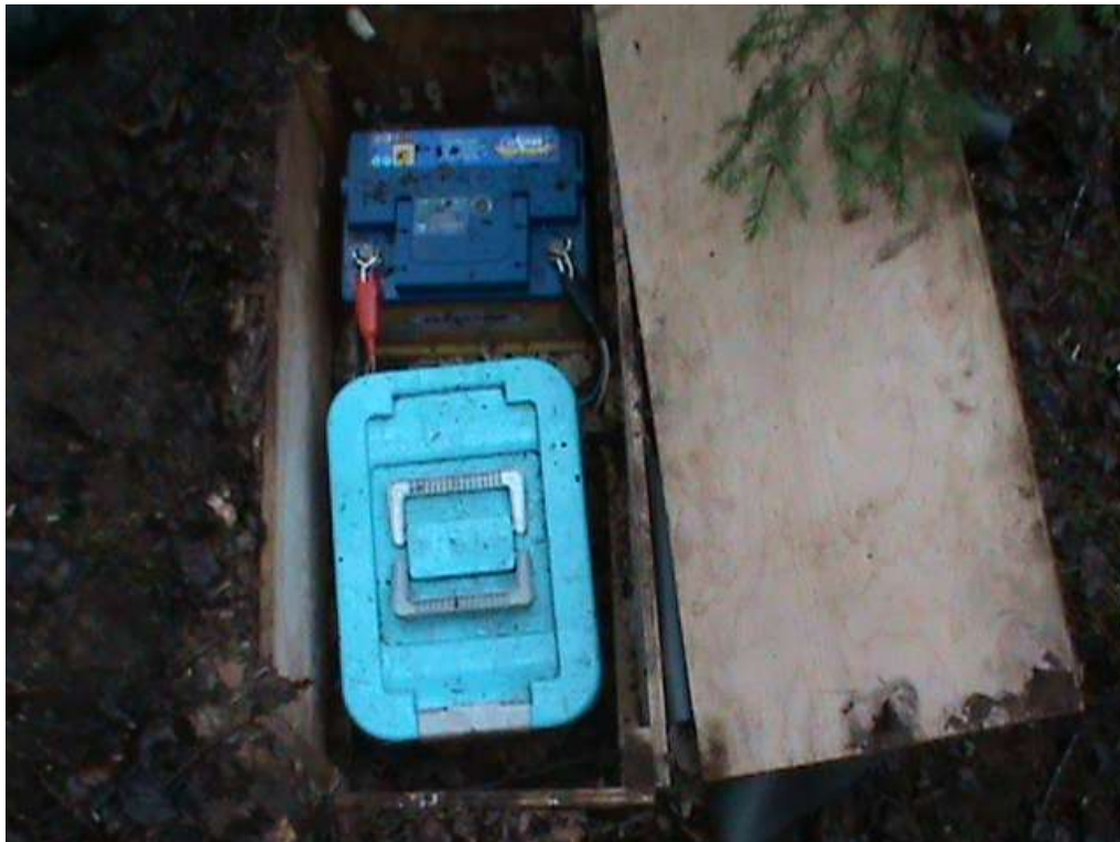
Рис. 18. Вид аккумуляторной батареи и иного оборудования для обеспечения работы замаскированной видеокамеры, установленной в стволе дерева для наблюдения за врезкой в трубопровод.
